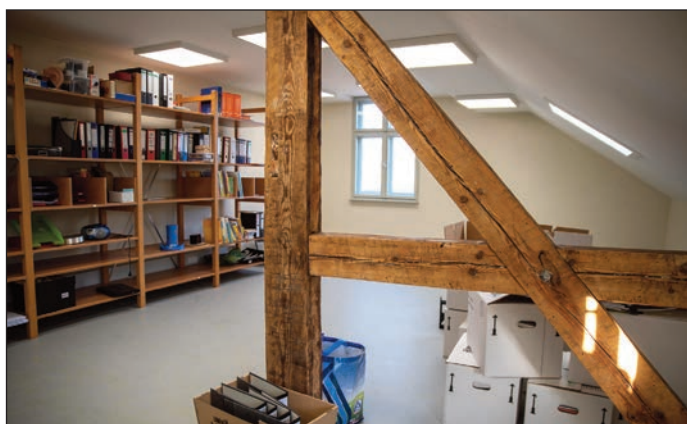
Auch das Dachgeschoss der Schule wird nun vollumfänglich genutzt.
